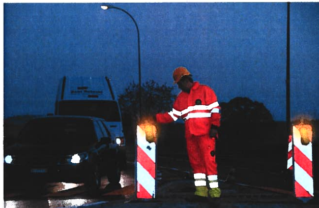
4 Indumenti ad alta visibilità (classe 3) in condizioni di semioscurità
