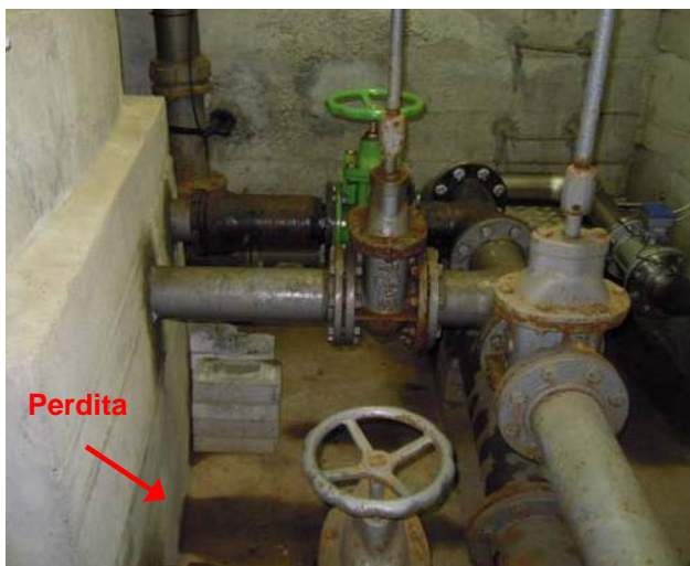
Foto 27 e 28: perdita d'acqua dalla vasca principale nella camera di manovra al piano inferiore
