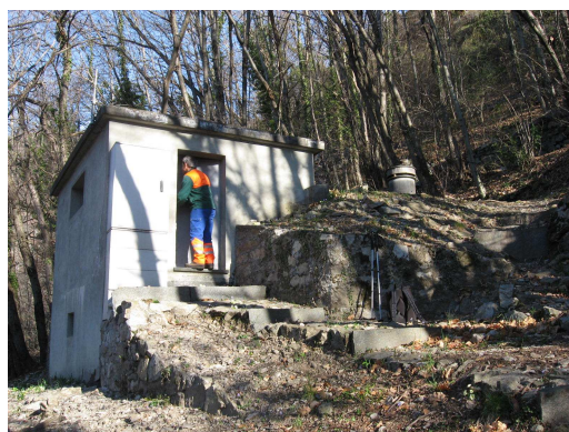
Serbatoio Pian Restell
