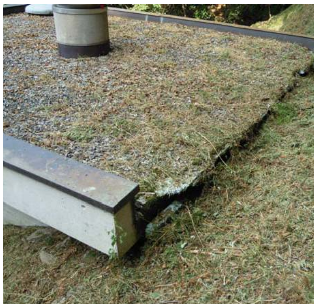
Foto 17 e 18: impermeabilizzazione e isolamento del tetto danneggiati
