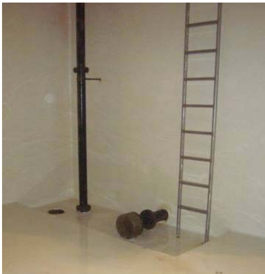
Foto 5: vasca di accumulo: settore con rivestimento ancora in buono stato
