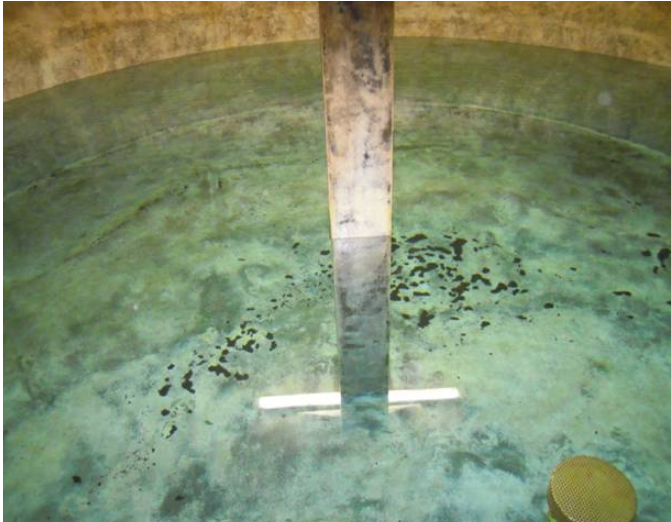
Foto 21: rivestimento vasca principale
