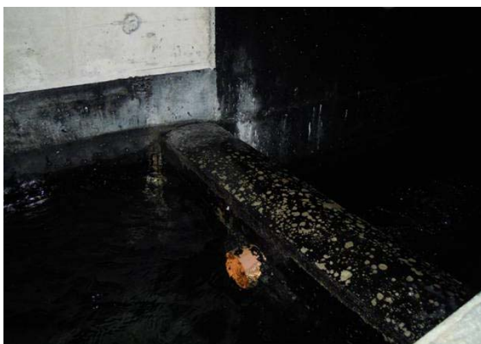
Foto 11 e 12: rivestimento della vasca e della vaschetta in entrata; anche il tubo di travaso in PVC non è conforme alle direttive.
