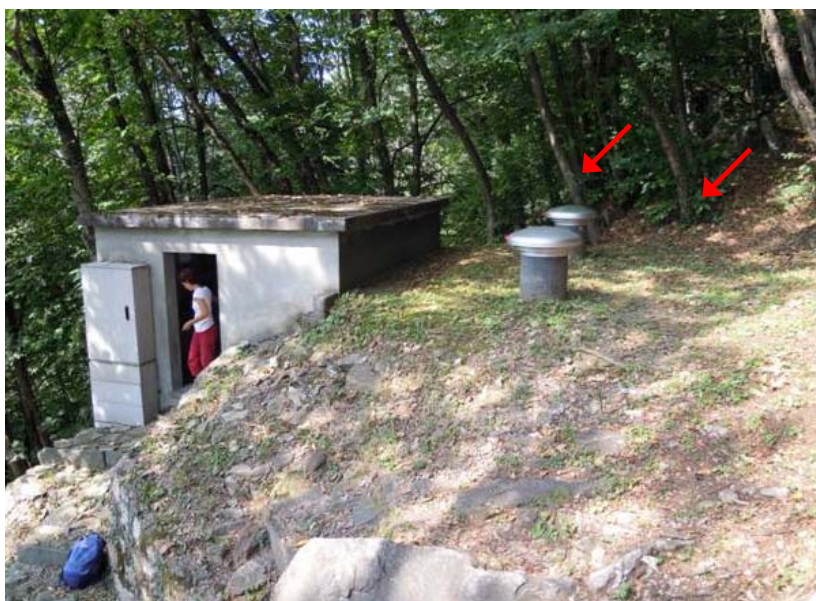
Foto 33: vista esterna del serbatoio
