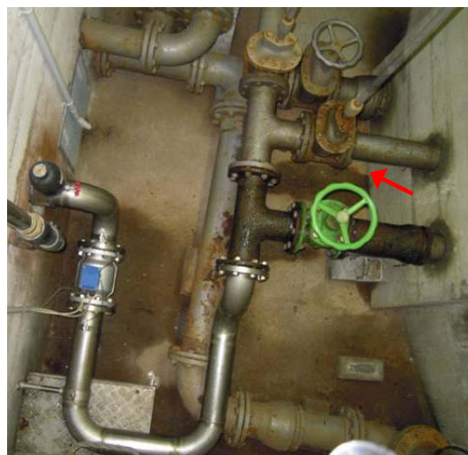
Foto 27 e 28: perdita d'acqua dalla vasca principale nella camera di manovra al piano inferiore
