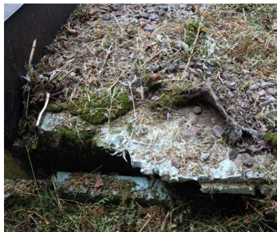
Foto 17 e 18: impermeabilizzazione e isolamento del tetto danneggiati
