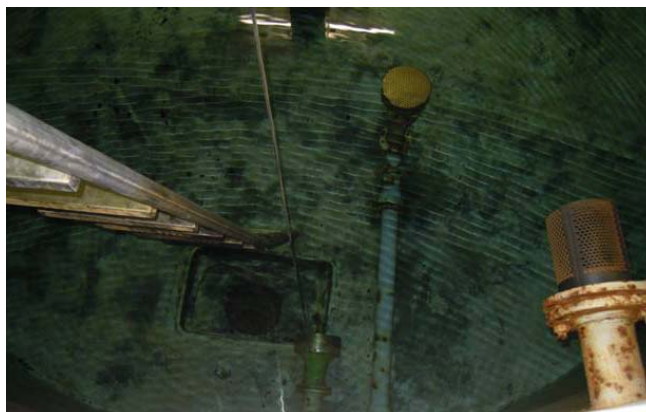
Foto 19 e 20: rivestimento vasca principale
