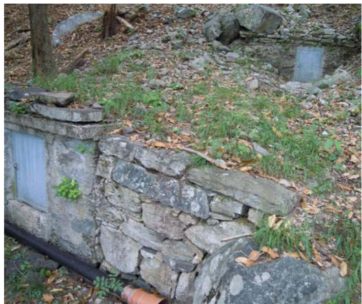
Foto 5: captazione sorgente Inferiore e camera di raccolta
