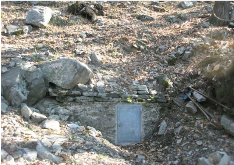
Foto 4: captazione sorgente Inferiore
