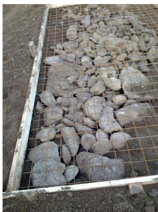
Massicciata quale fondo antigelivo e di supporto per la successiva posa del basamento in calcestruzzo
