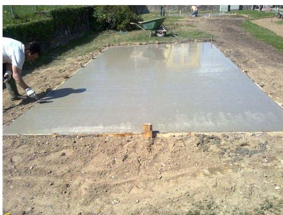
Preparazione della platea che accoglierà le lastre antitrauma in gomma
