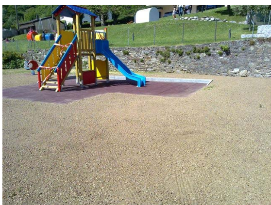
Basamento ricoperto con lastre di gomma
