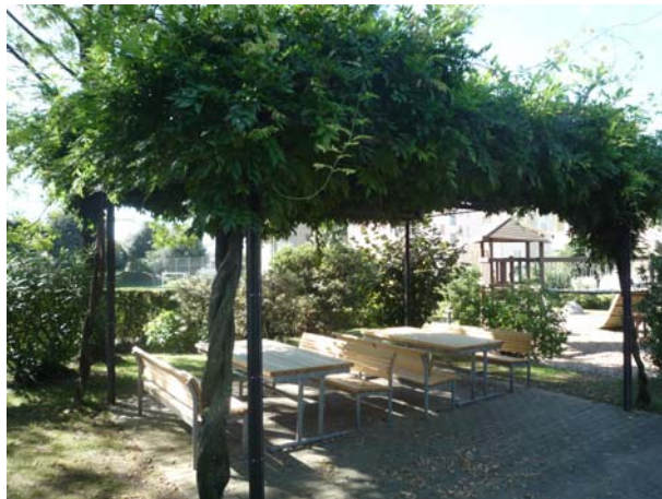
Pergolato costituito da una struttura metallica e ricoperta da piante rampicanti (glicine) che ne garantiscono l'ombreggiatura.
