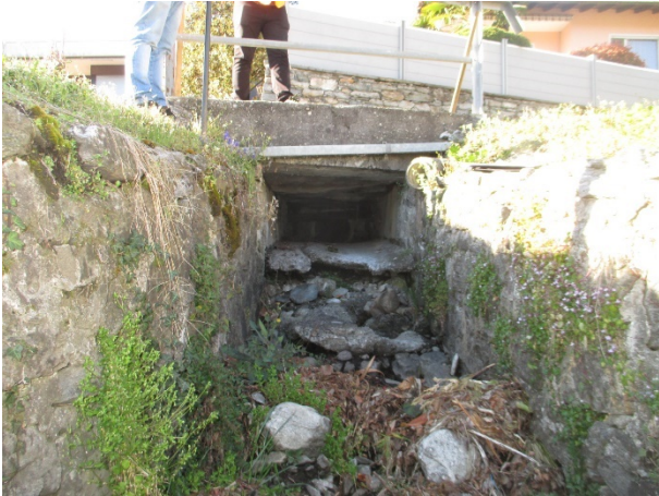
Figura 3: Stato attraversamento corso d'acqua presso pozzetto no. 34A
