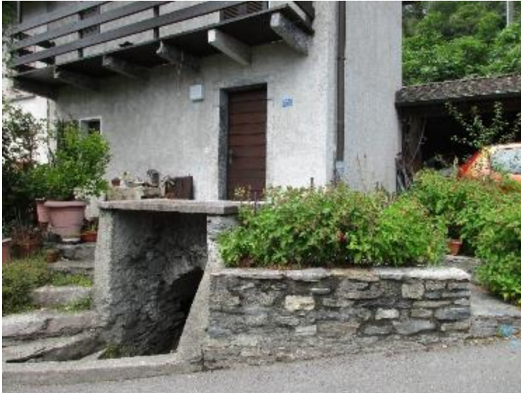
Figura 6 Edificio al mapp. 1583
