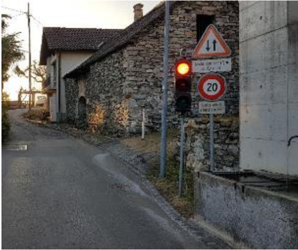
Figura 7 Segnaletica verticale da eliminare a fine cantiere
