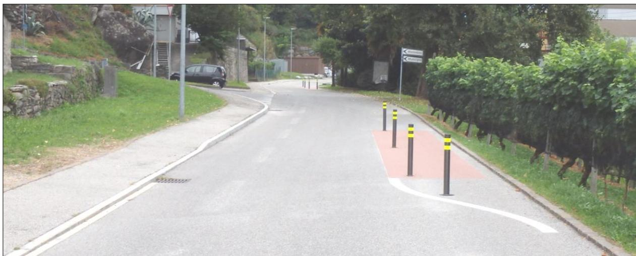
*Esempio concreto di applicazione MODULO 3, demarcazione colorata e posa di paletti di protezione/guida e demarcazione della linea guida di colore bianco che indica la presenza di un ostacolo da scansare.*
