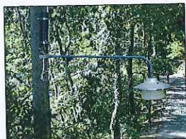
Armatura Miniroda con lampadine ai vapori di mercurio (50 W)
