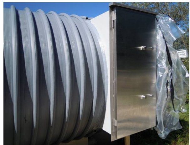
Foto 2 e 3: esempio: interno di un serbatoio in PP e porta di accesso
