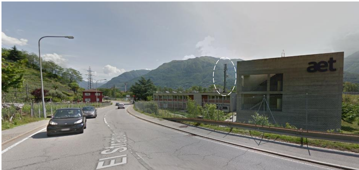
Antenna sulla sede di AET a Monte Carasso, poco distante dalla centrale elettrica (Google maps, 2019)
