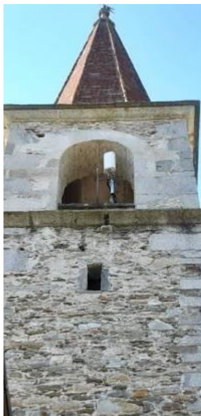
Antenna di telefonia nel campanile di Arcegno (La Regione, 4.9.2020)
