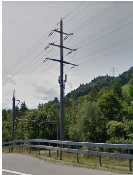
Antenne su pali dell'alta tensione a Fully (lungo l'autostrada) e a Spiez (Google maps, 2019)
