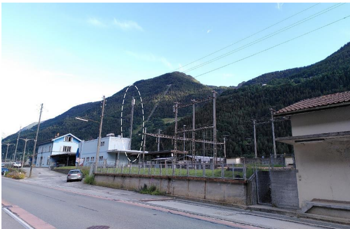
Antenna presso la stazione di Ambri-Piotta (30 giugno 2021)
