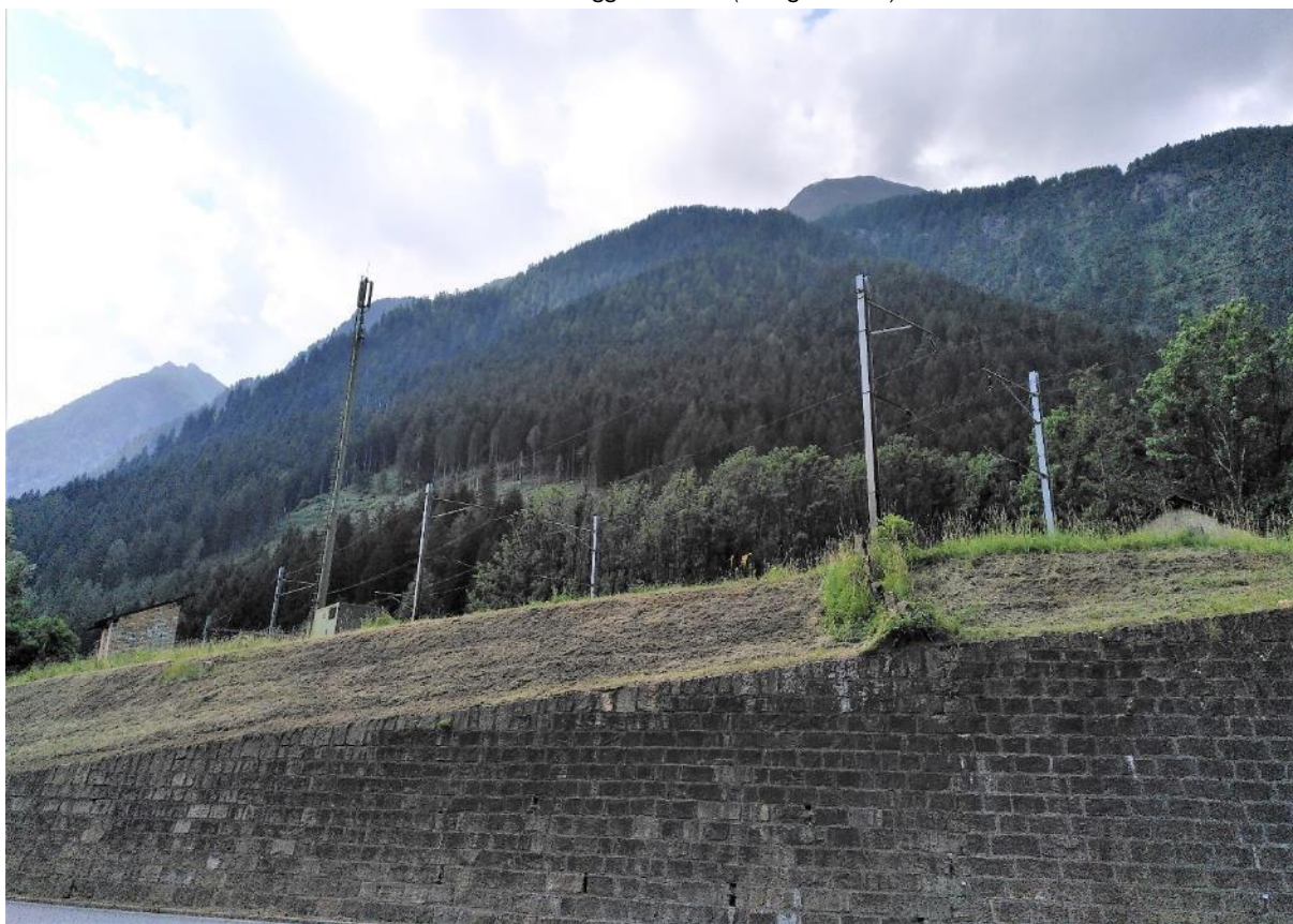
Antenna accanto alla ferrovia a Quinto (22 luglio 2021)
