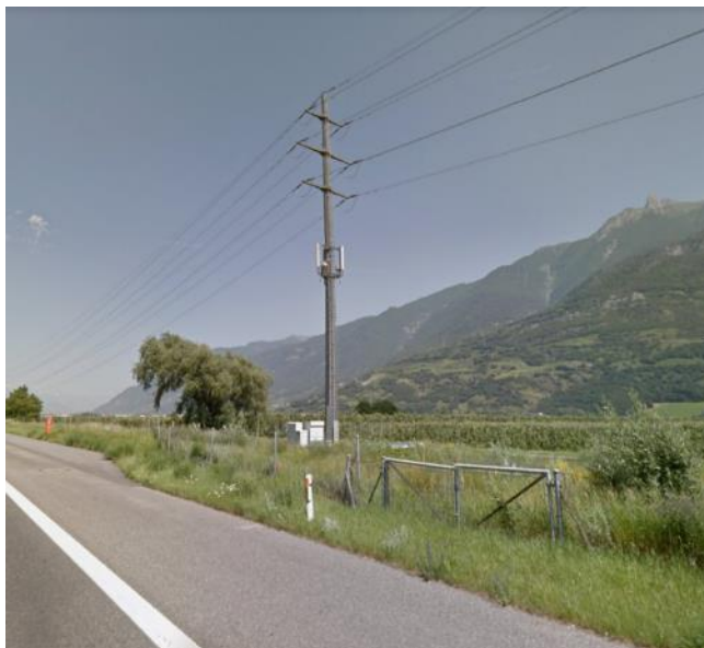
Antenne su pali dell'alta tensione a Fully (lungo l'autostrada) e a Spiez (Google maps, 2019)
