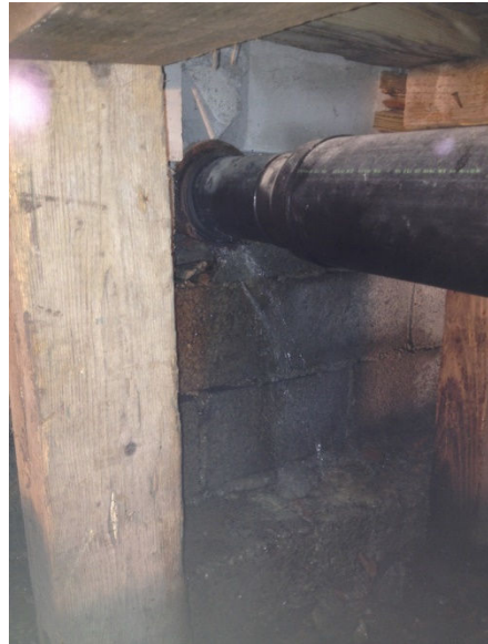
Risanamento collettore nel vespaio
