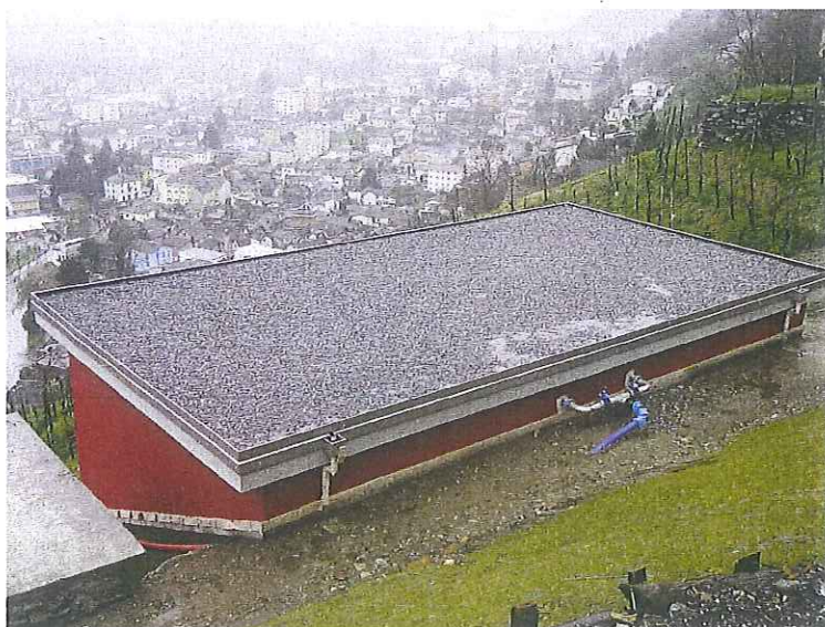
Figura 5: Esempio realizzazione risanamento tetto
