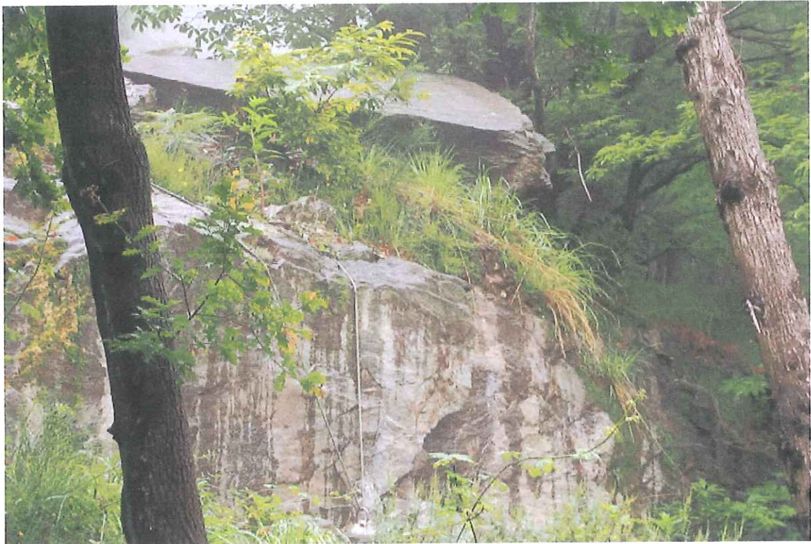
Figura 3: Vista laterale dell'ammasso roccioso.
