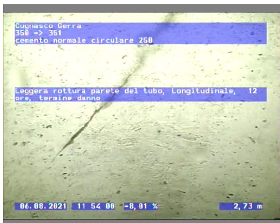
Fotografia: 8_8_31_A.JPG 2.73m, Leggera rottura parete del tubo, Longitudinale, 12 ore, termine danno
