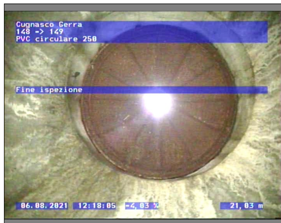
Fotografia: 9_9_42_A.JPG 21.03m, Fine ispezione
