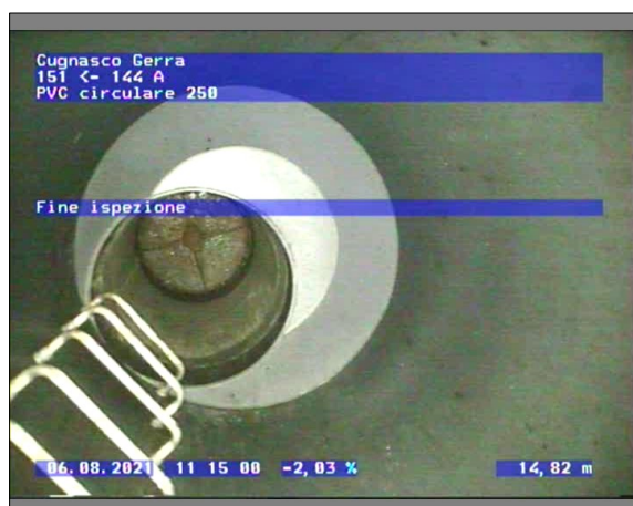
Fotografia: 1_1_14_A.JPG 14.82m, Fine ispezione
