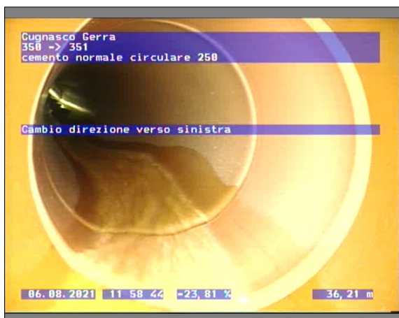
Fotografia: 8_8_35_A.JPG 36.21m, Cambio direzione verso sinistra
