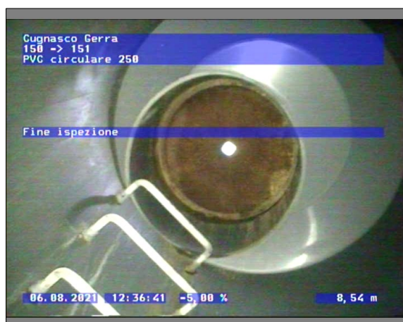
Fotografia: 11_11_54_A.JPG 8.54m, Fine ispezione
