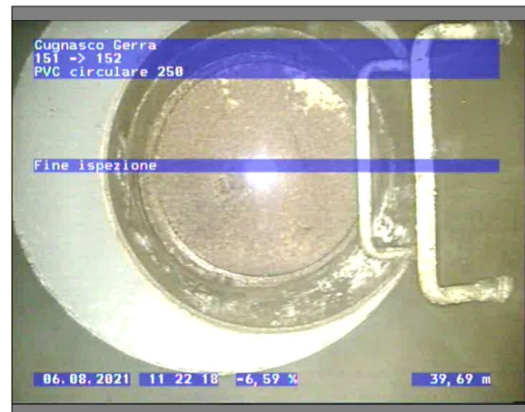
Fotografia: 4_4_18_A.JPG 39.69m, Fine ispezione
