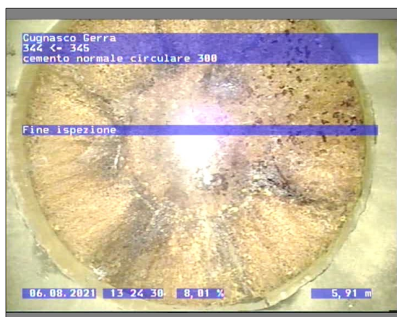
Fotografia: 16_16_75_A.JPG 5.91m, Fine ispezione
