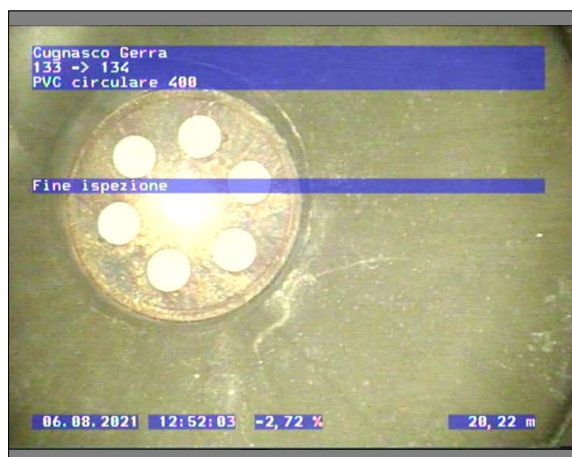
Fotografia: 13_13_62_A.JPG 20.22m, Fine ispezione
