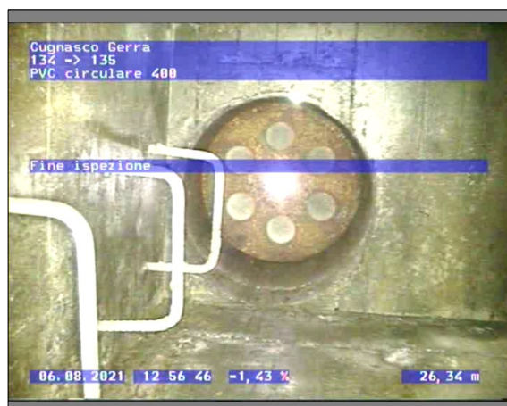
Fotografia: 14_14_68_A.JPG 26.34m, Fine ispezione
