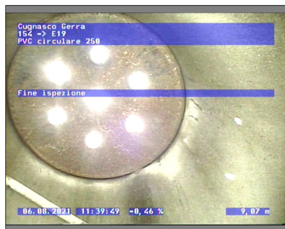
Fotografia: 7_7_28_A.JPG 9.07m, Fine ispezione
