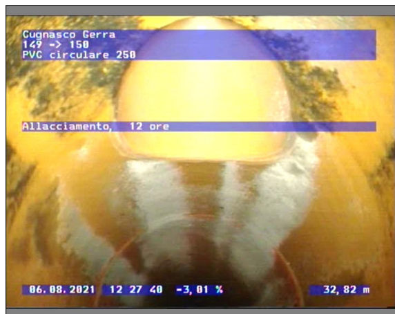
Fotografia: 10_10_47_A.JPG 32.82m, Allacciamento, 12 ore
