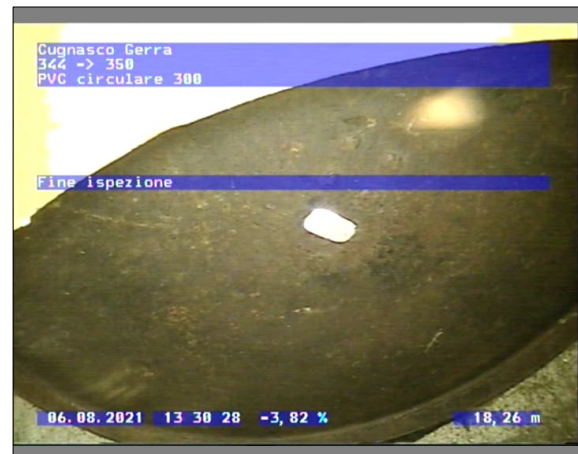
Fotografia: 17_17_79_A.JPG 18.26m, Fine ispezione
