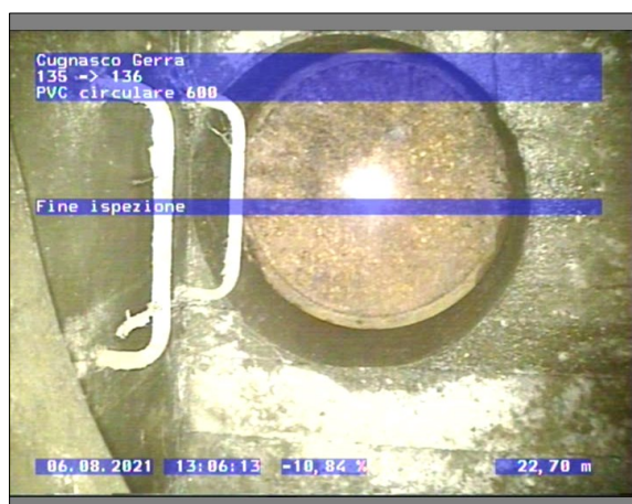
Fotografia: 15_15_71_A.JPG 22.7m, Fine ispezione
