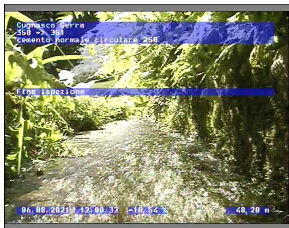
Fotografia: 8_8_37_A.JPG 48.2m, Fine ispezione
