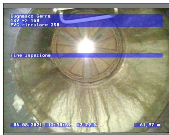
Fotografia: 10_10_50_A.JPG 61.97m, Fine ispezione
