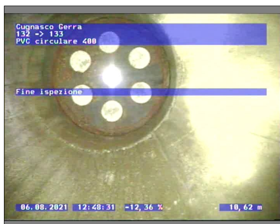
Fotografia: 12_12_57_A.JPG 10.62m, Fine ispezione
