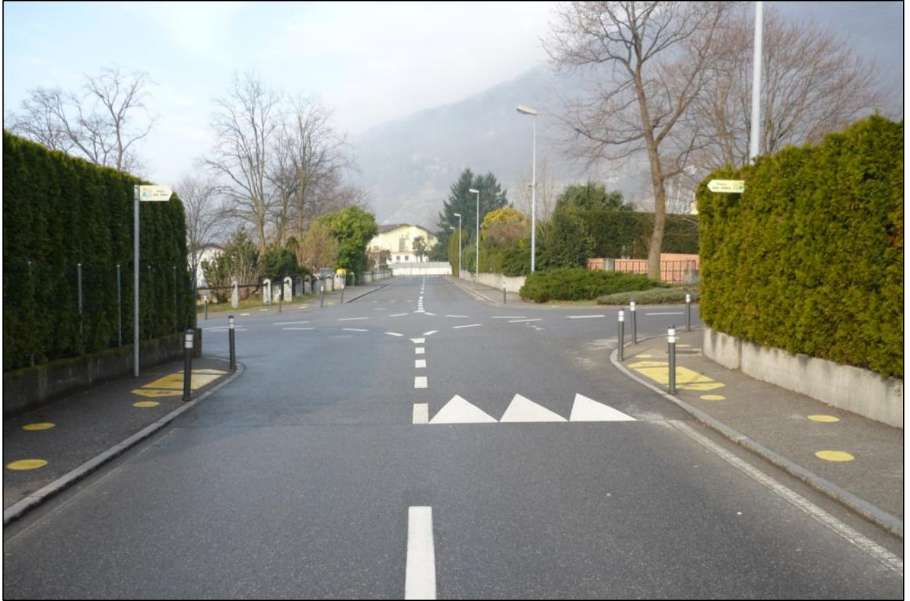
Esempio di intersezione con segnaletica orizzontale che annuncia la precedenza da destra
