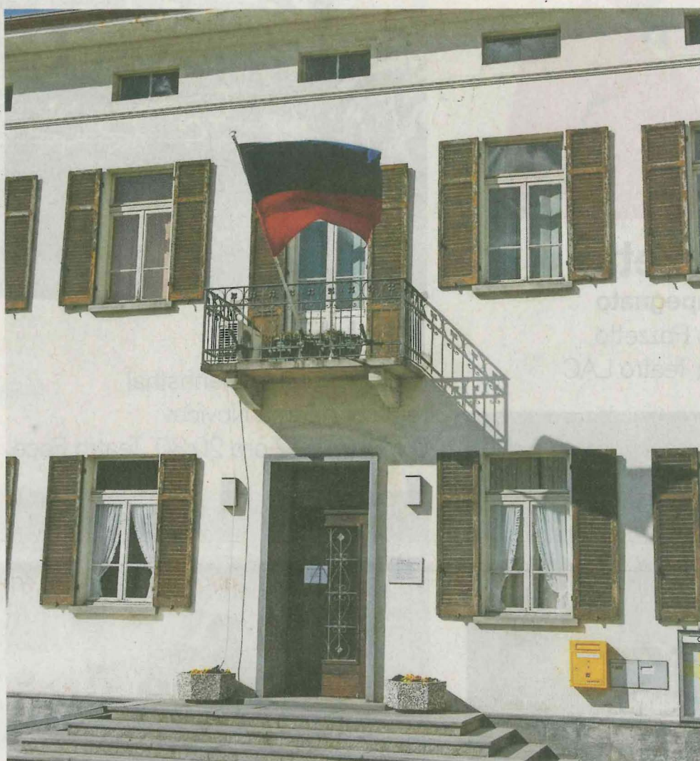
ADDIO La vecchia casa comunale di Gerra Piano, che ospita attualmente una delle sezioni di scuola dell'infanzia e che in futuro sarà demolita. (Foto Archivio CdT)
