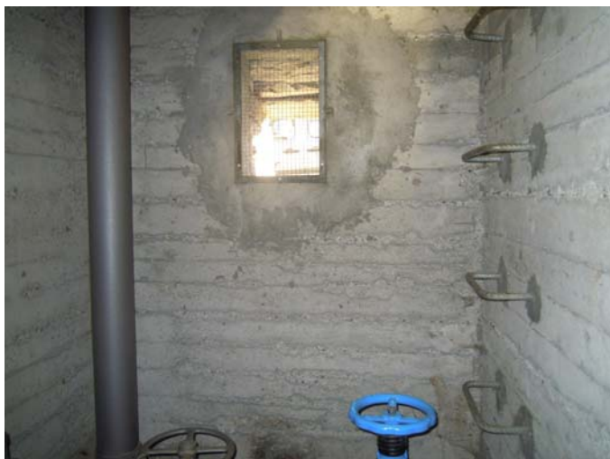
Foto 8: scalini tra il locale superiore e quello inferiore
